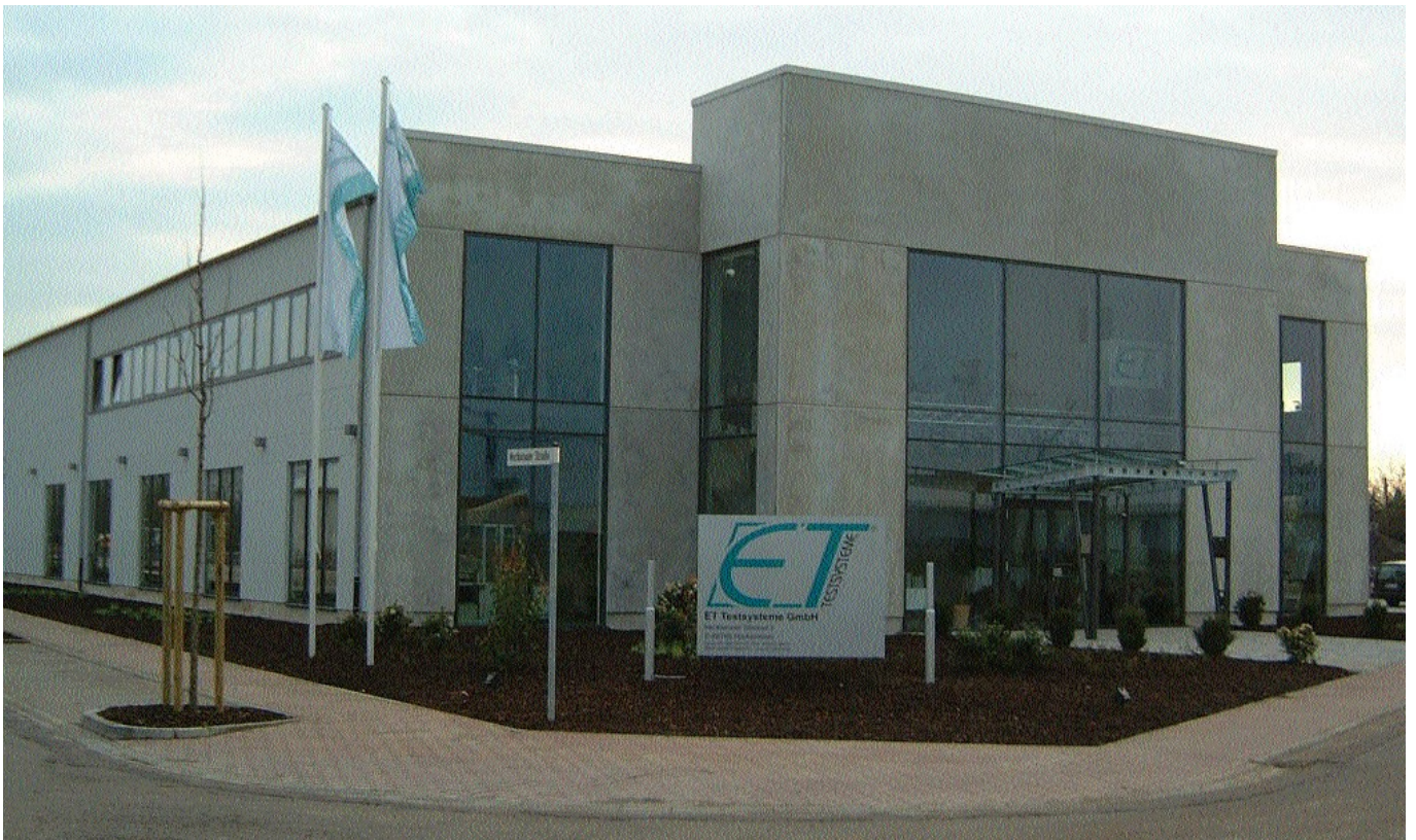
Produktions- und Bürogebäude der ET Instrumente und ET Testsysteme in Hockenheim
